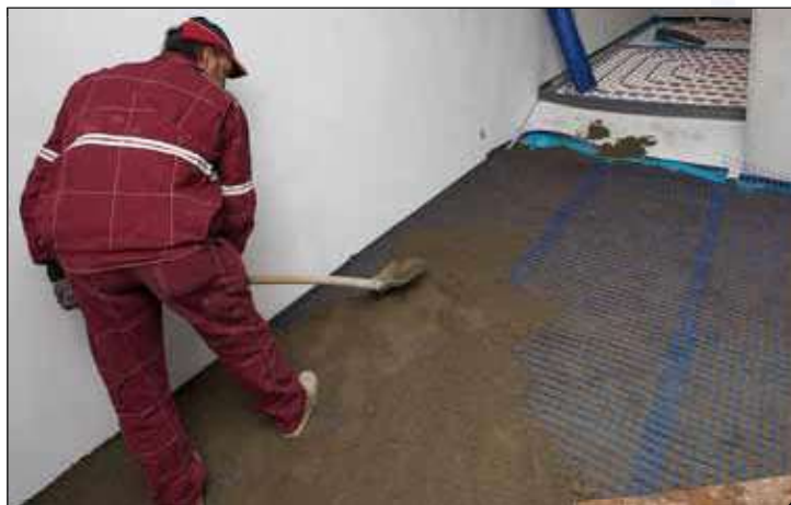
Mise en oeuvre de Chap'rol sous chape traditionnelle
