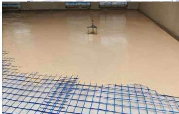
Mise en oeuvre de Chap'rol sous chape fluide autonivelante
